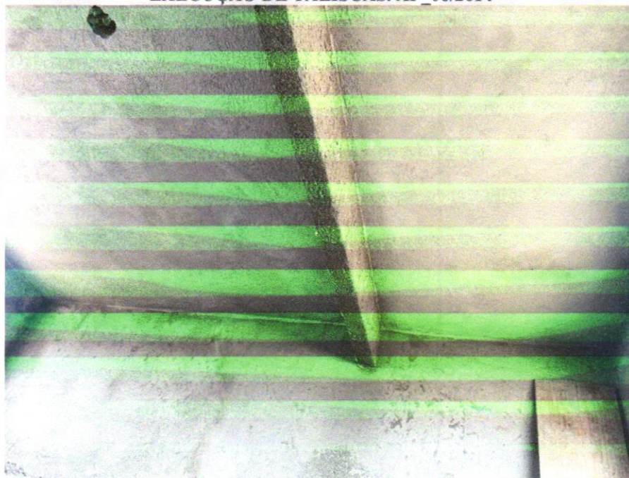
IMAGEM 12 – EMBOÇO, PARA RECEBIMENTO DE CERÂMICA, EM ARGAMASSA TRAÇO 1:2:8, PREPARO MECÂNICO COM BETONEIRA 400L, APLICADO MANUALMENTE EM FACES INTERNAS DE PAREDES, PARA AMBIENTE COM ÁREA ENTRE 5M2 E 10M2, ESPESSURA DE 20MM, COM EXECUÇÃO DE TALISCAS. AF_06/2014
