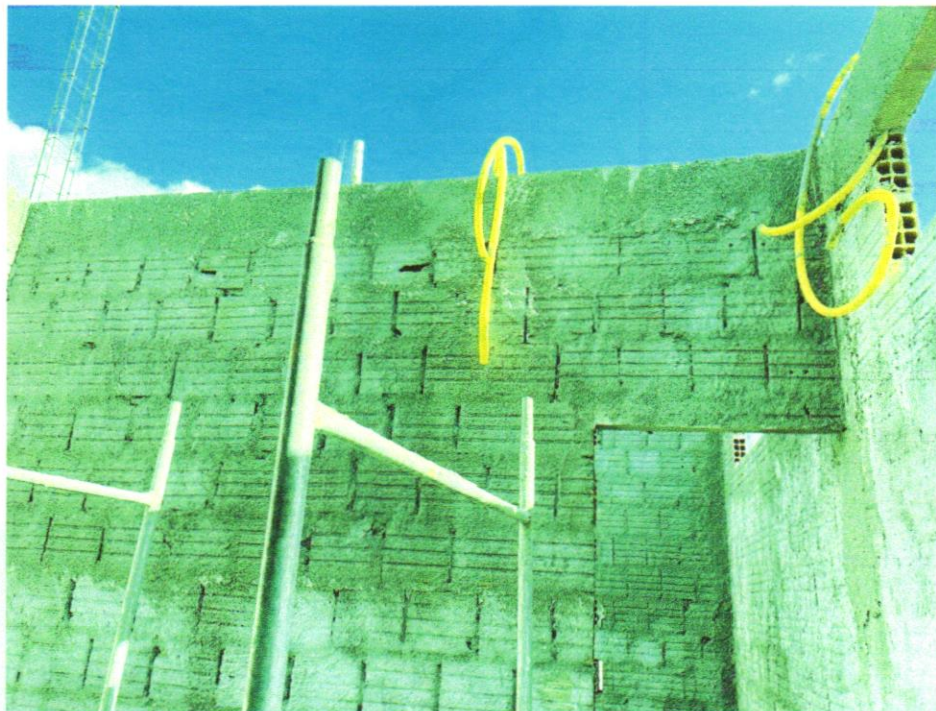
IMAGEM 01 - MONTAGEM E DESMONTAGEM DE FÔRMA DE VIGA, ESCORAMENTO COM PONTALETE DE MADEIRA, PÉ-DIREITO SIMPLES, EM MADEIRA SERRADA, 4 UTILIZAÇÕES. AF_09/2020
